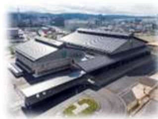
松江市総合体育館
